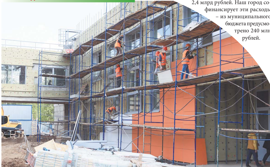
Идут работы по строительству пристройки к школе № 9
